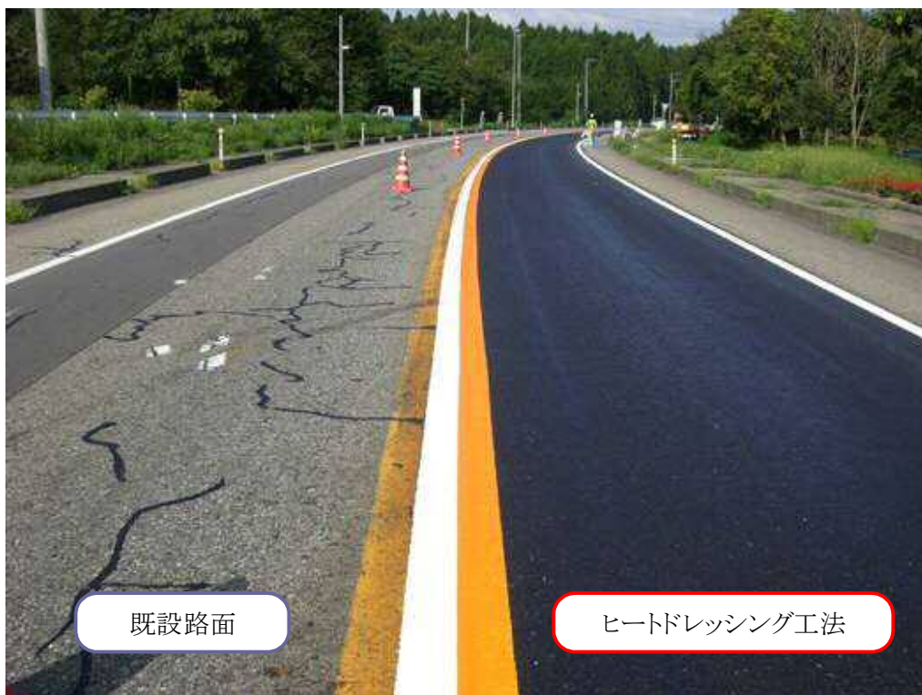
ヒートドレッシング工法により補修した路面
