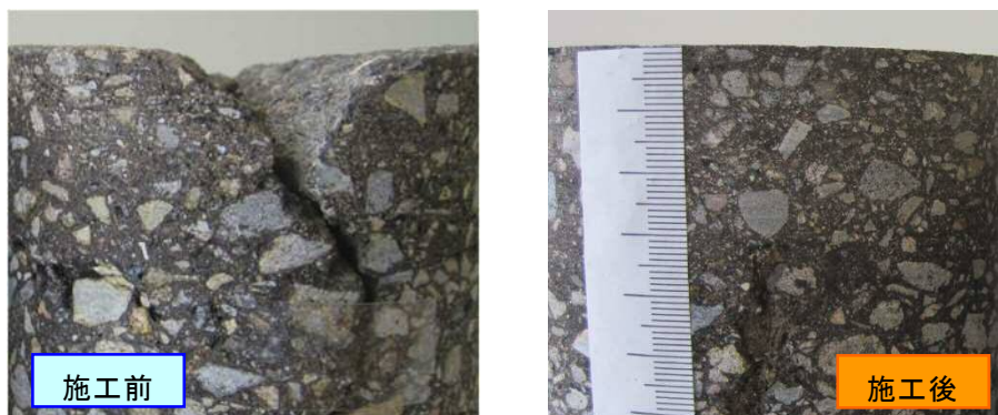
写真－２ ヒートドレッシング工法前後の切取供試体
