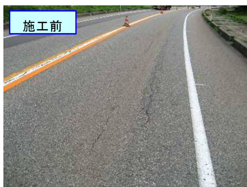
写真－１ ヒートドレッシング工法前後の舗装路面
